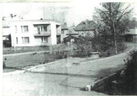
Jožami nádrž, část ulice na návsi, střecha s nejvyšší vodou v obci
